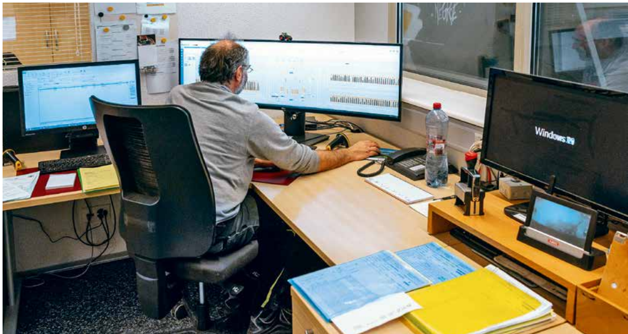
Digitalisierte Steuerungsanlage in einer Mühle
